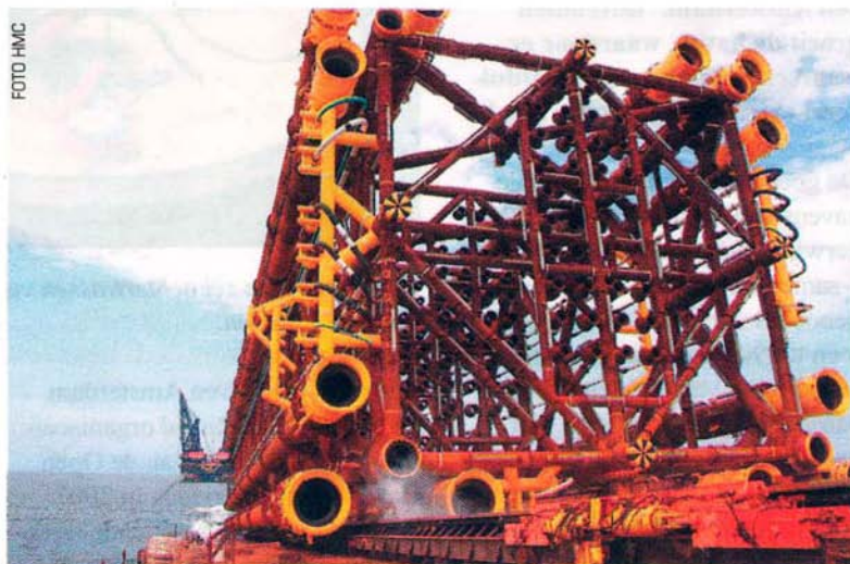
De onderste sectie van het stalen jacket met op de achtergrond het kraanschip Thialf.
