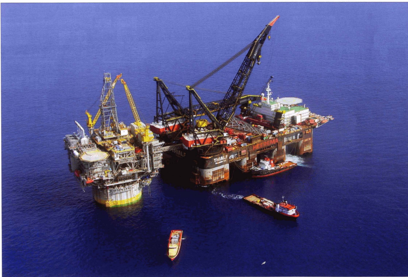
Kraanschip 'Thialf' van Heerema Marine Contractors.
