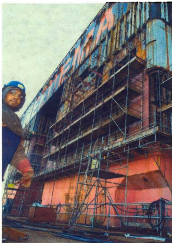
Lassers vervangen doorgeroeste stalen wandplaten.
