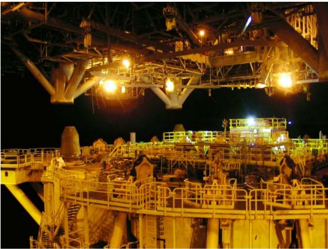
Het moment net voordat de Thialf van Heerema de 'topsides' op de cilindervormige 'spar' van de Perdido plaatst (beeld: Shell)
